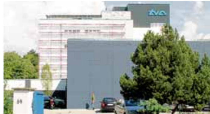
Die Parkplätze wurden gepflastert, der Turm aufgestockt, die Turnhalle energetisch saniert – der TVA hat sich rundum erneuert.
